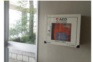
体育館入口左側
