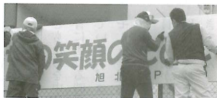
看板設置作業
